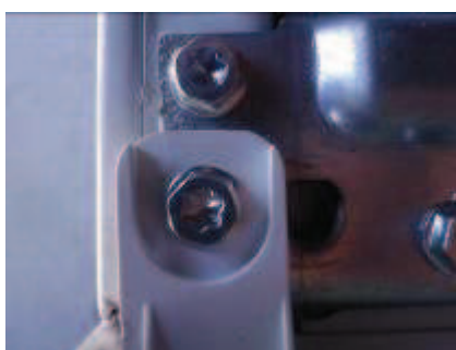
Vue du dessus : (torx T20 x2) / 2 vis diam 5,5mm/ clip du bandeau
